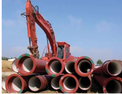
Der Bau von Wasserleitungen: Die enge Zusammenarbeit von Deutschland und Jemen ist auch ein Anliegen der EMA. (Foto: schweitzer-degen/Fotolia.com)
