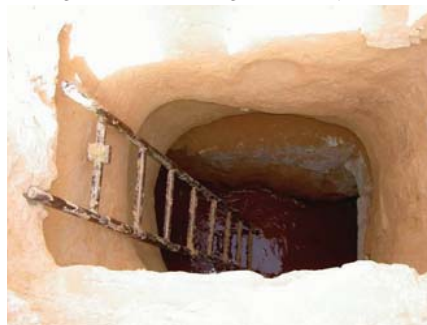
Tief unter der Erde verläuft das altorientalische Kanalsystem der Foggaras. (Foto: GTZ Algerien)
